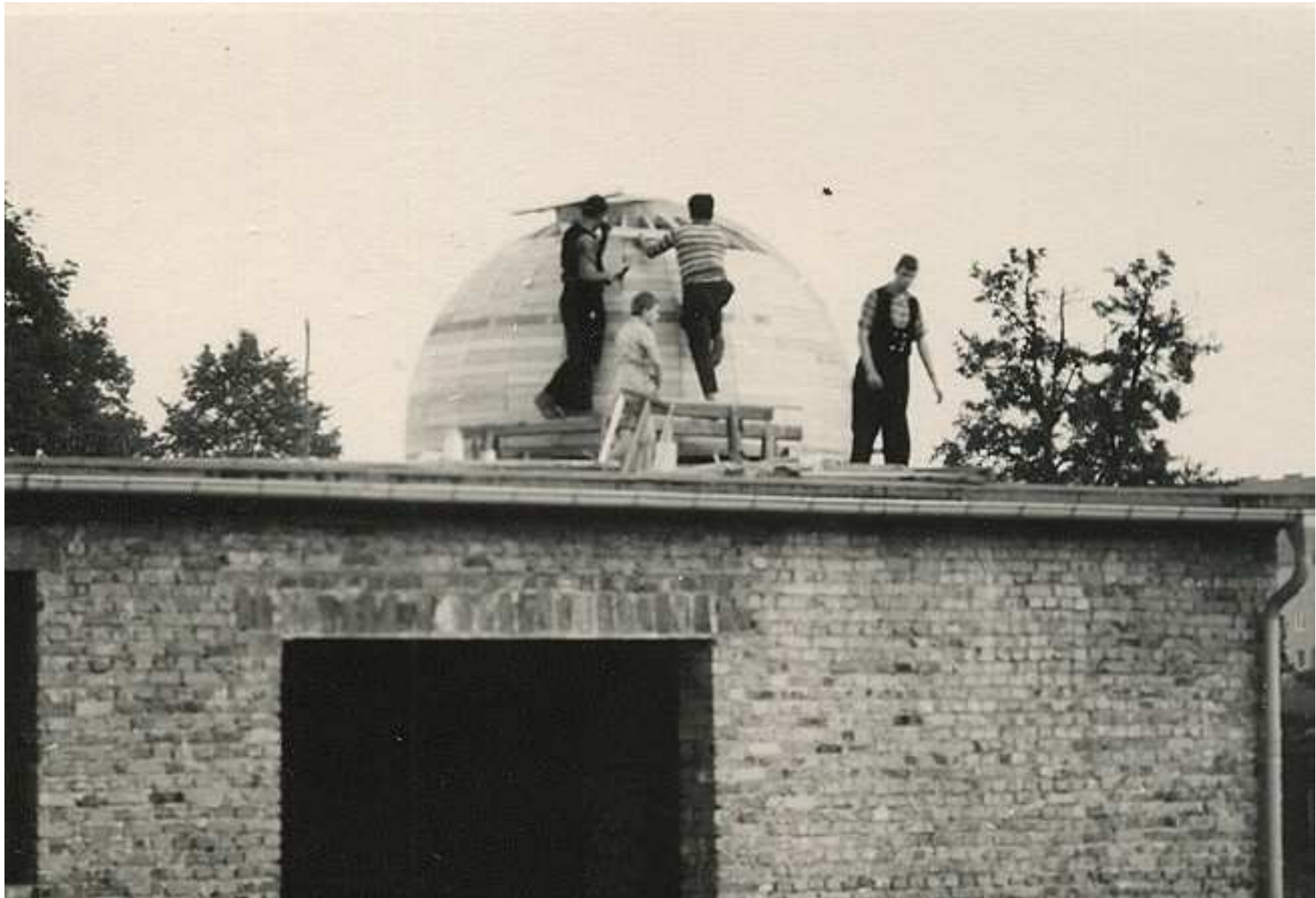
Die Verschalung ist abgeschlossen ...
