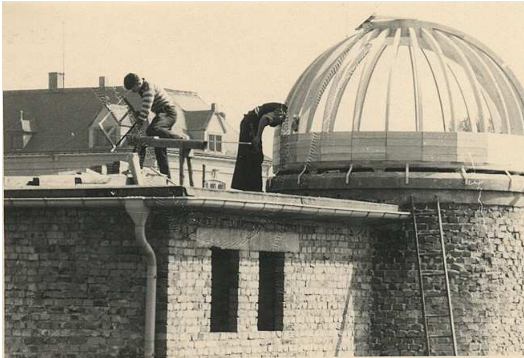
Zimmerleute bauen die Kuppel
